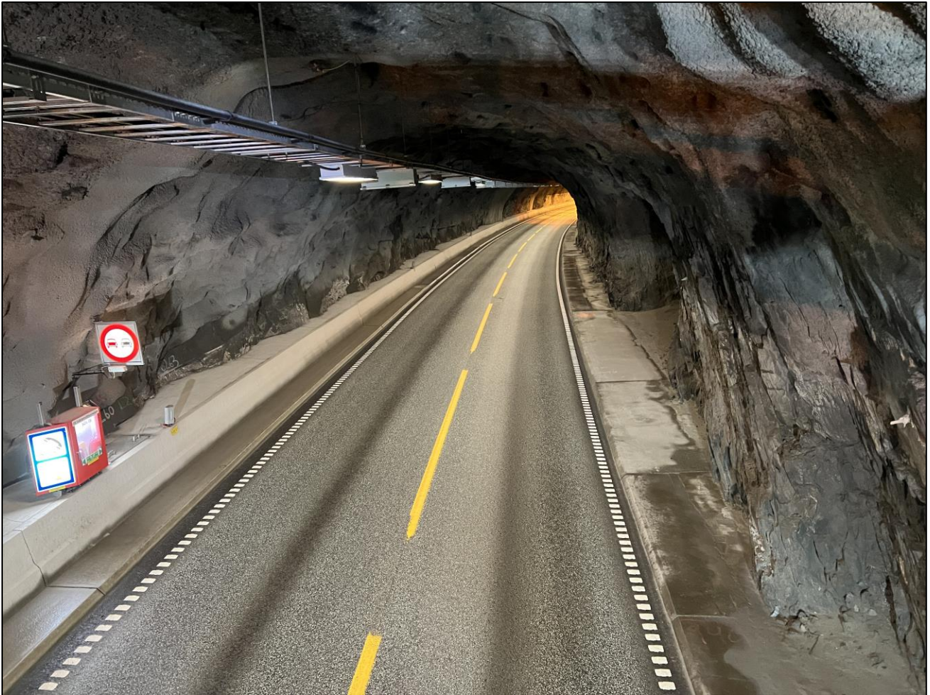
Foto 5. Generelle forhold i Saksenviktunnelen. Tunnelen er delvis sikret med brannsikret PE-skum og fiberarmert sprøytebetong. Det er også et mindre parti med nett som er delvis innsprøytet med betong.
