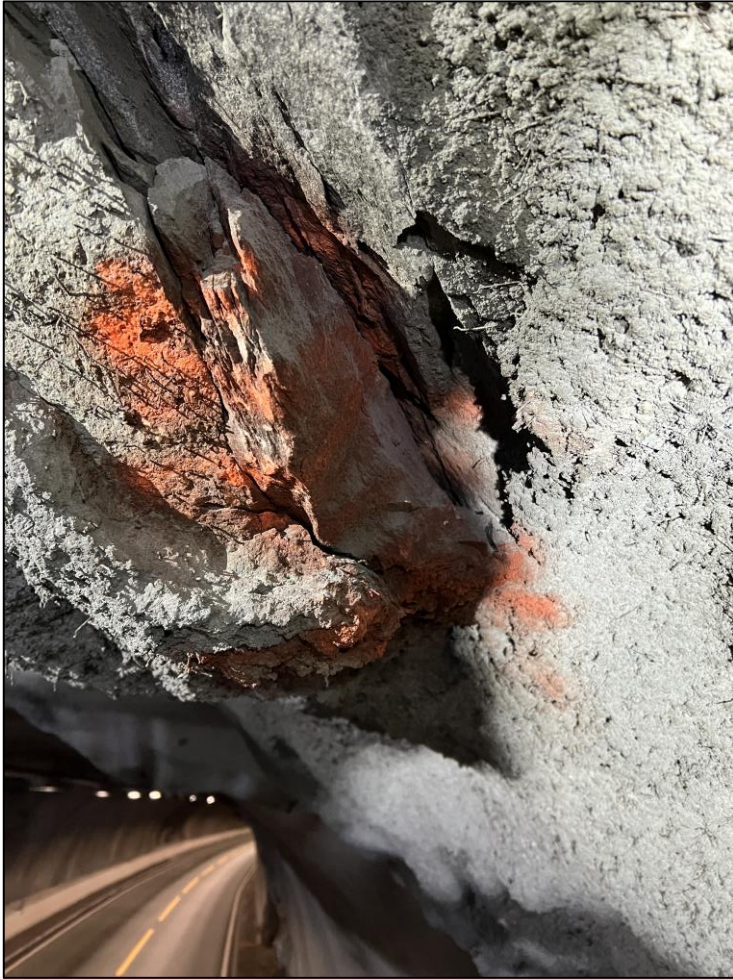
Foto 8. Eksempel på avløst blokk markert for rensk ved pel 650, høyre side.
