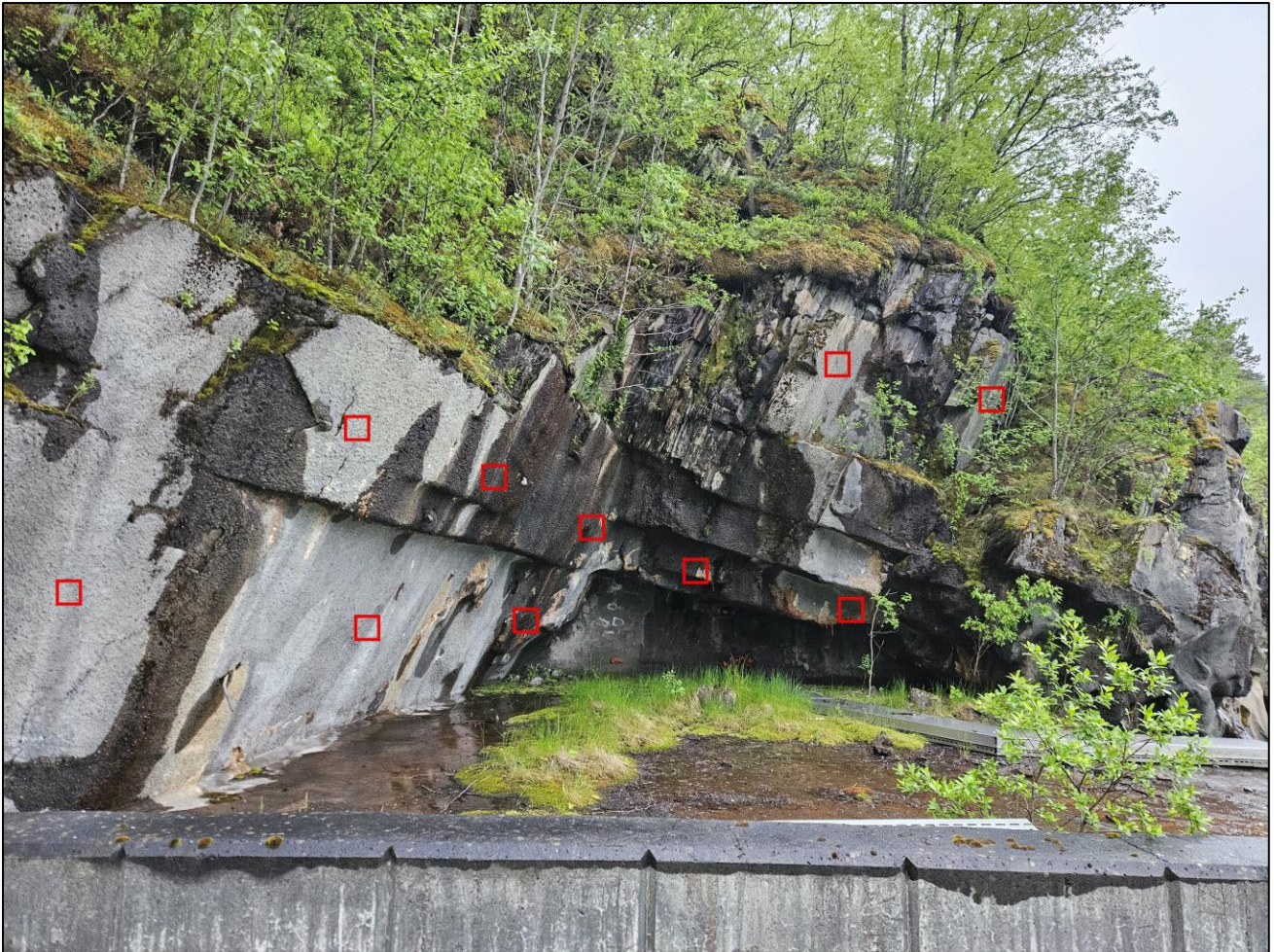
Foto 3. Oversiden av nordlig tunnelportal. Det anbefales at dette partiet sikret med 10 stk. 4,0 m lange bolter, fullt innstøpt. Boltene må være forankret minimum 1 m i godt berg.
