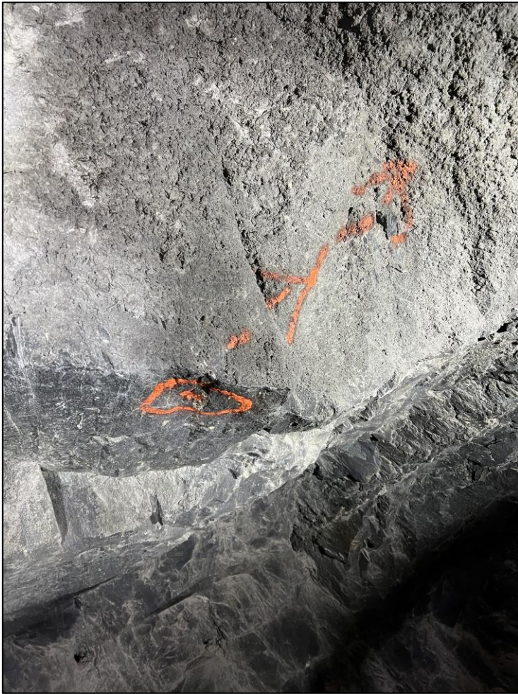
Foto 7. Eksempel på bolteanvisning i avløst blokk ved pel 440, høyre side. Pilen angir anbefalt bolteretning.
