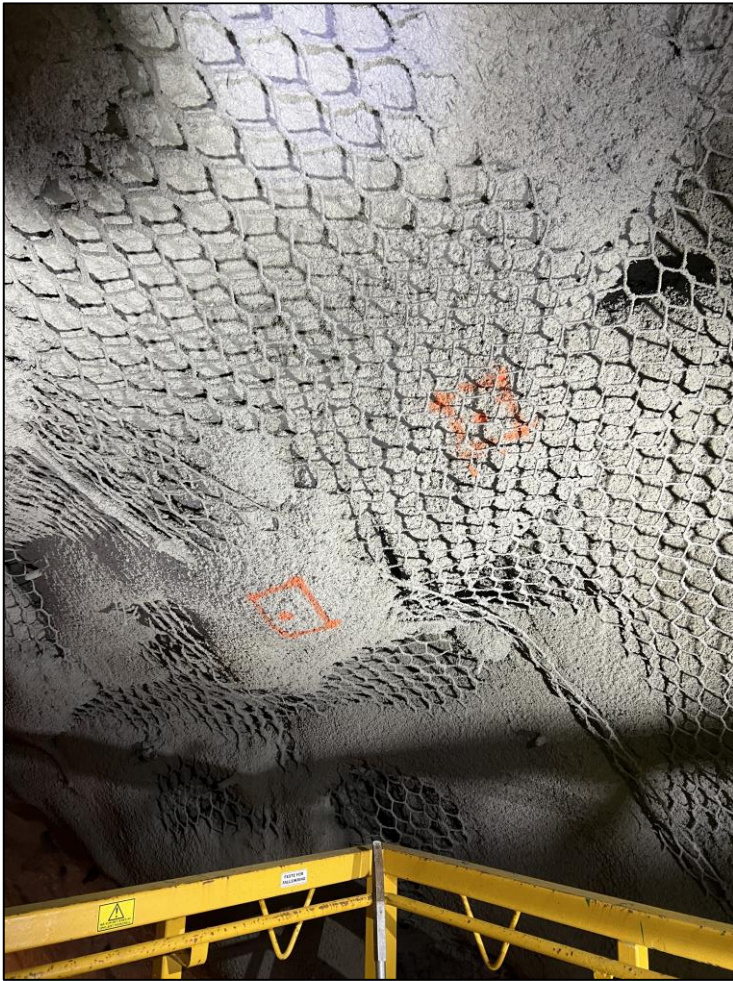
Foto 10. Eksempel på anvist bolt (4,0 m) i parti med bom i sprøytebetong bak nett ved pel 982, høyre side.
