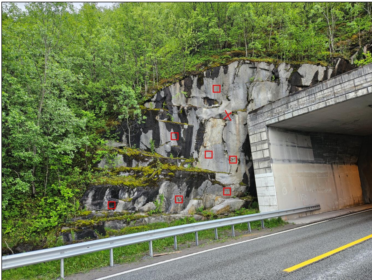
Foto 2. Oversikt over nordlig tunnelportal og forskjæring. Det anbefales spettrensk av løs sprøytebetong og mindre blokk, samt 7 stk. bolter med lengde på 4,0 m fullt innstøpt. Boltene må være forankret i minimum 1 m godt berg. Det anbefales videre vegetasjonsrensk av omtrent 20 trær på skjæringstopp og i skjæringen.
