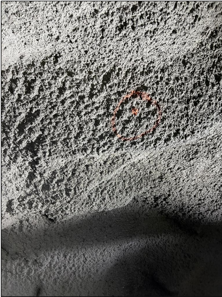
Foto 9. Eksempel på anvist boltesikring ved bom i sprøytebetong ved pel 940, høyre side.
